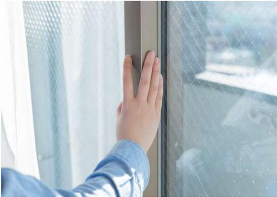
日当たりの良い野外に面した板ガラスは、まれに、直射日光が当たることによってガラスが破損することがあります。これを熱割れ現象と言います。野外に面した窓ガラスでは、日射を直接受けた部分は日射熱を吸熱して高温となり膨張する一方、アルミサッシに組み込まれた部分や、日差しが当たらない影の部分はあまり温度上昇せず低温のままとなります。この温度差が結果としてガラスに歪みが発生し、こ
